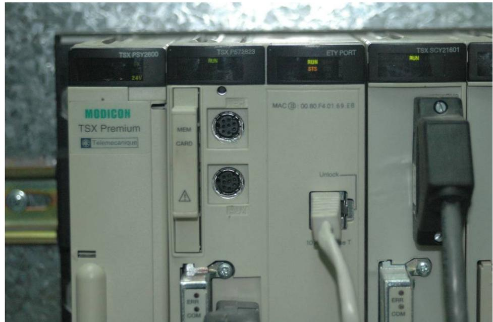
La fotografía superior nos muestra los pilotos de las diferentes tarjetas de la Estación PLC que nos facilitan una primera información sobre el estado de los diferentes módulos.
