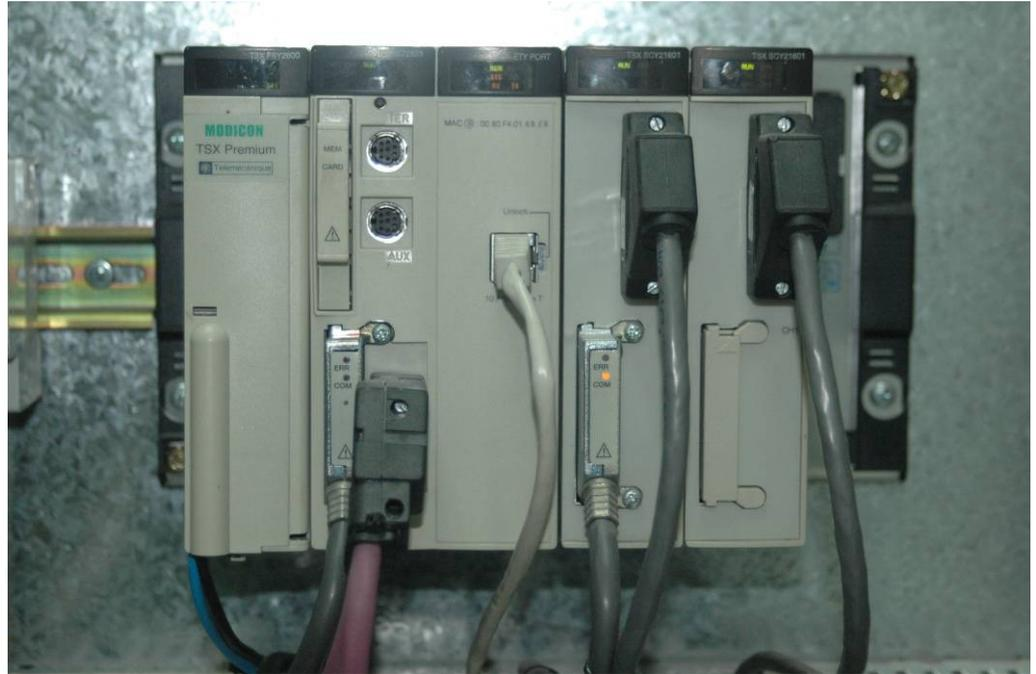
Las Estaciones PLC o Automatas del ECOPARQUE de La Rioja son del tipo TSX-57 PREMIUM de Telemecanique y tienen una arquitectura muy similar. Veamos sus principales elementos en la imagen que se muestra y que corresponde al PLC de ENVASES:
